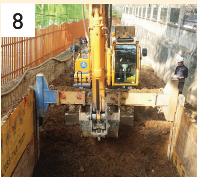
원하는 깊이까지 터파기를 하면서 판넬과 레일을 압입하면서 상판까지 설치한다.
